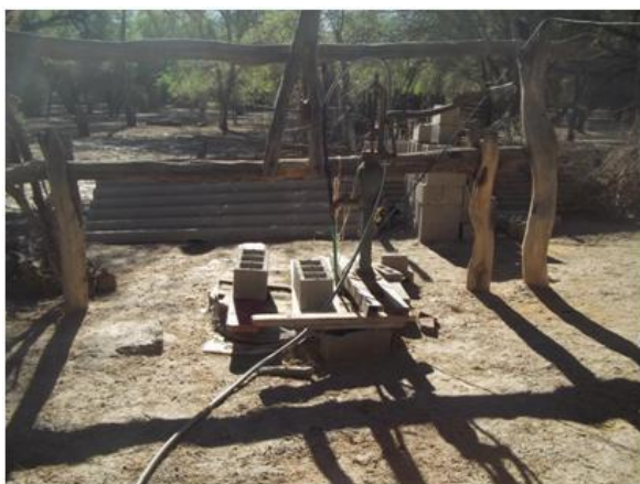
Fig. 13. Fuente de abastecimiento de agua de la Escuela.
