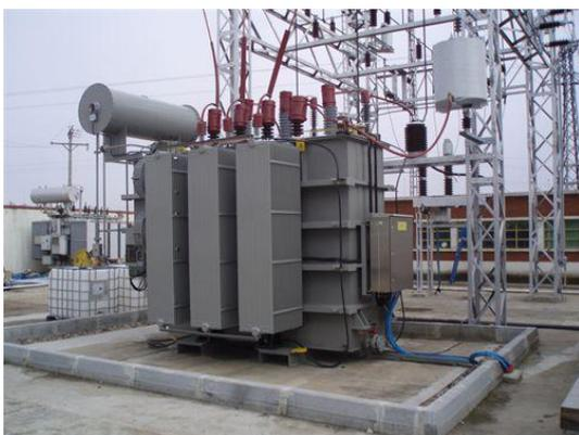
Fig. 15 Transformador de 25MW
