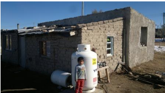
Fig. 1: Vivienda de adobe, mampostería y chapa.
