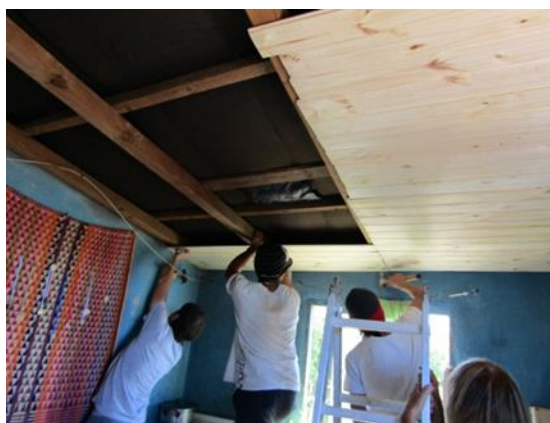
Fig. 16: Comunidad de laguna Blanca aislando una vivienda del paraje.
