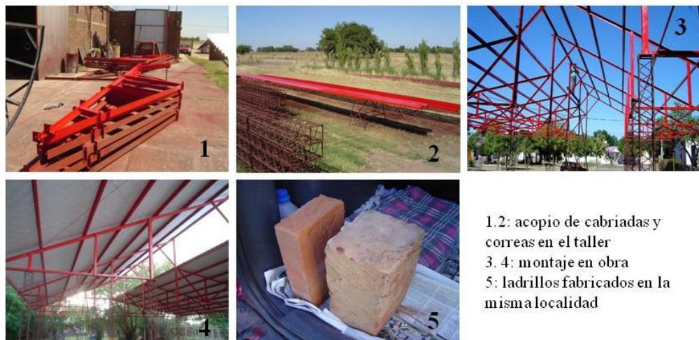
Fig. 4: Producción local de componentes tecnológicos. Armado de la cubierta como primera etapa de la construcción del edificio hacia 2006
