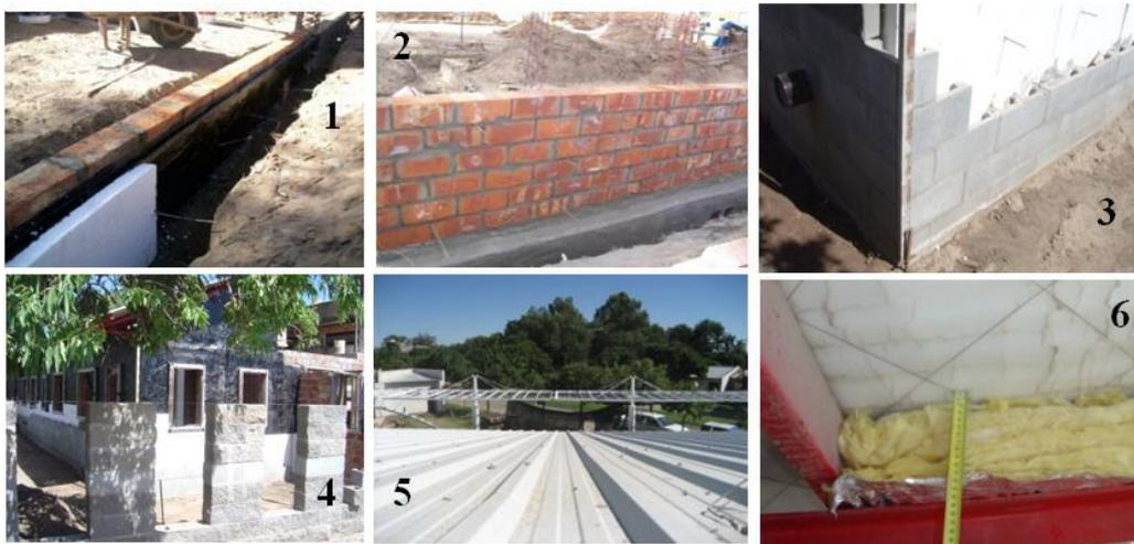
Fig. 6: Detalles constructivos en obra. Referencias: 1-aislación hidrófuga-térmica en el cimiento (ver detalle constructivo en el diseño); 2- masa térmica; 3- aislación térmica en envolvente vertical; 4- barrera de vapor en la envolvente y pre-marco de madera en vano (ver detalle constructivo en el diseño); 5- cubierta de chapa pre-pintada; 6- aislación térmica de la cubierta
