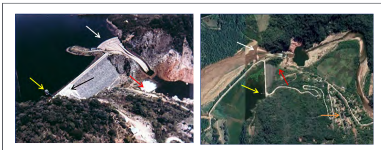
Figura 2. Izquierda: Vista hacia el NO de la presa en 1983, antes de su colmatación. Las flechas indican: el vertedero (blanca), la torre de toma (amarilla), la válvula de chorro hueco (roja) y la zona colapsada y reparada sobre el estribo derecho (negra). Derecha: Imagen actual de la presa, obtenida de Google Earth. Las flechas indican: el vertedero (blanca), la torre de toma (amarilla), la válvula de chorro hueco (roja) y la planta potabilizadora (ocre).
