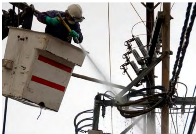
Figura 9. Bombero realizando limpieza en el tendido eléctrico en Villa la Angostura. Foto tomada el 15 de junio de 2011 por Osvaldo Peralta.
