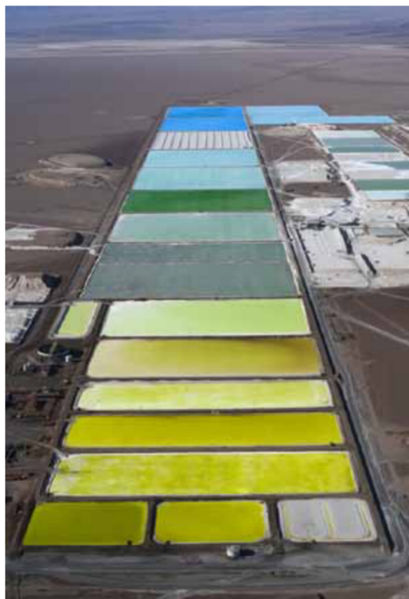
Figura 7: Piletones de evaporación en el Salar de Atacama, Chile.
