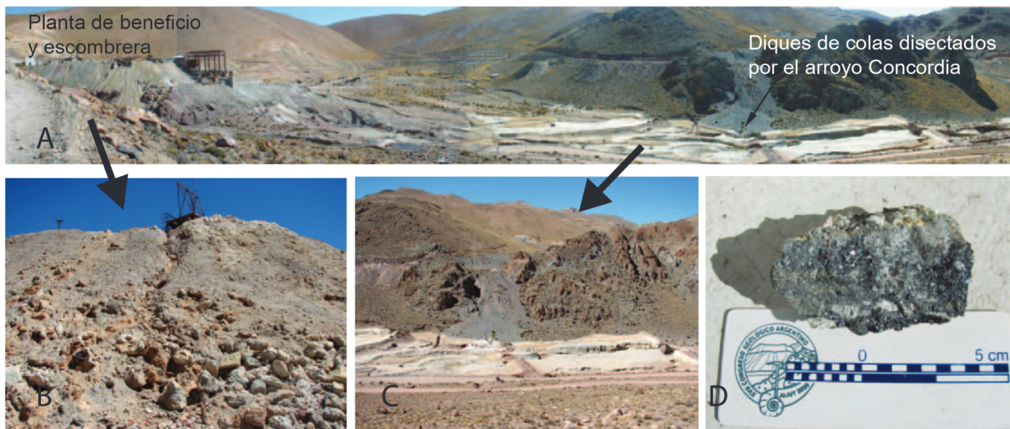
Figura 6. A. Vista panorámica de la mina abandonada Concordia, provincia de Salta, se observa que el arroyo Concordia atraviesa los diques de colas. B. Escombrera, compuesta por fragmentos de roca de diferente tamaño. C. Diques de cola disectados por el arroyo Concordia. Fotos: Marcelo Arnosio. D. Muestra de mineral de mena de plomo (galena PbS) que se extraía de las vetas de la mina. Foto: Natalia Salado Paz.
