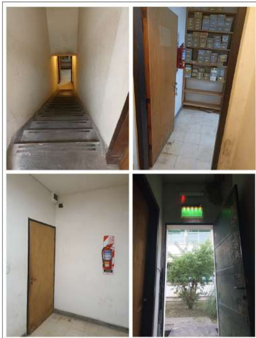
Figura 4. Adecuaciones de Higiene y Seguridad en el espacio de guarda (cintas antideslizantes en los escalones, instalación de extintor, señalética de salida, luces de emergencia y mejoras eléctricas).
