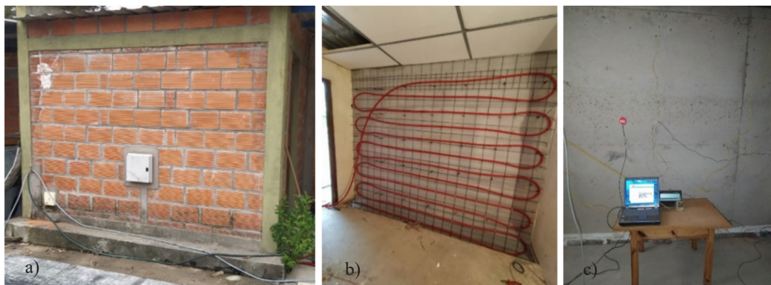
Fig. 3: Pared con el sistema APES en casilla experimental del INENCO, a) vista exterior, b) vista interior de la distribución de los tubos y c) monitoreo sobre el tabique terminado.
