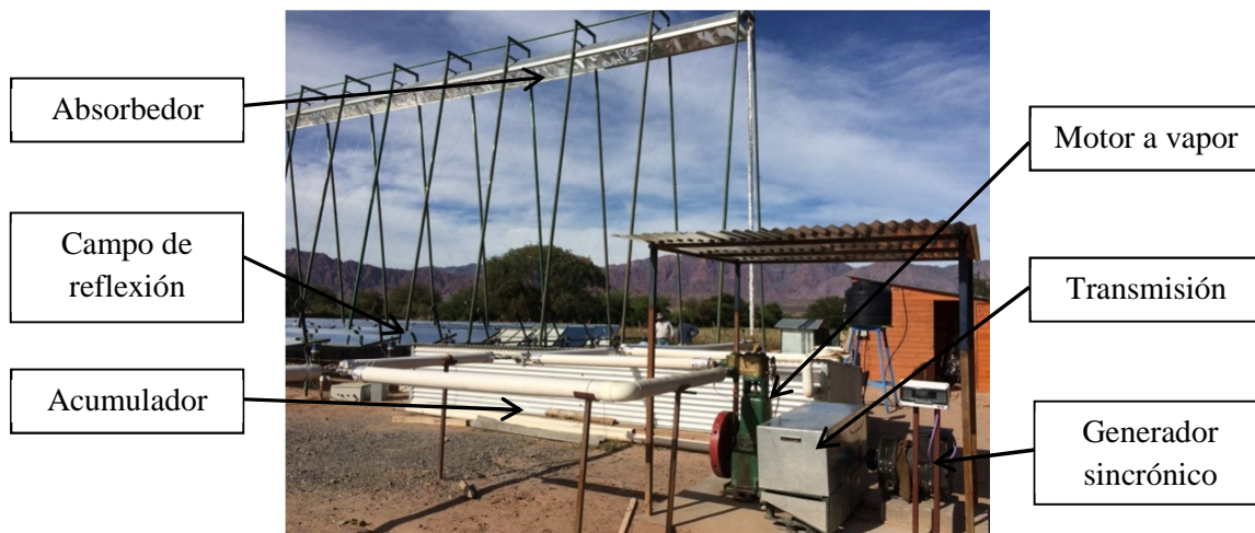
Figura 2: partes del sistema Fresnel Lineal.
