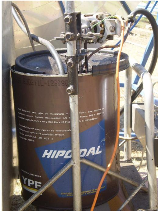
Figura 3. Sistema de almacenamiento y circulación del aceite
