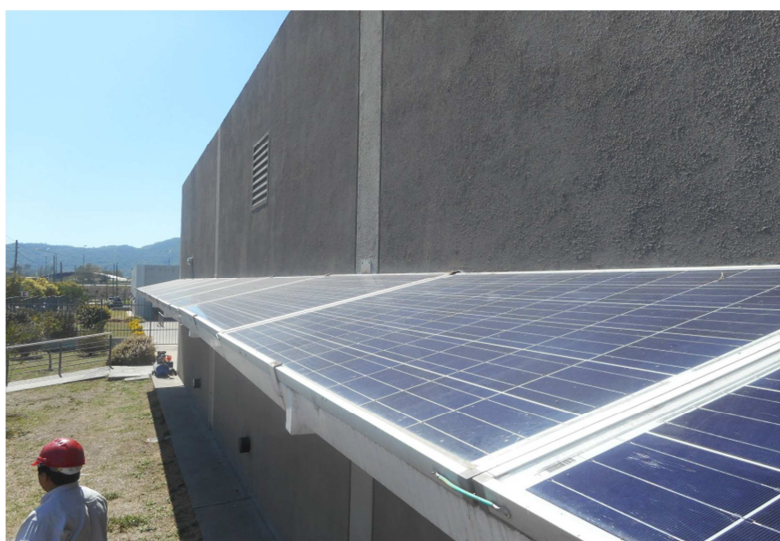
Figura 2: Sistema Fotovoltaico conectado a red interna en el Poder Judicial de Salta.
