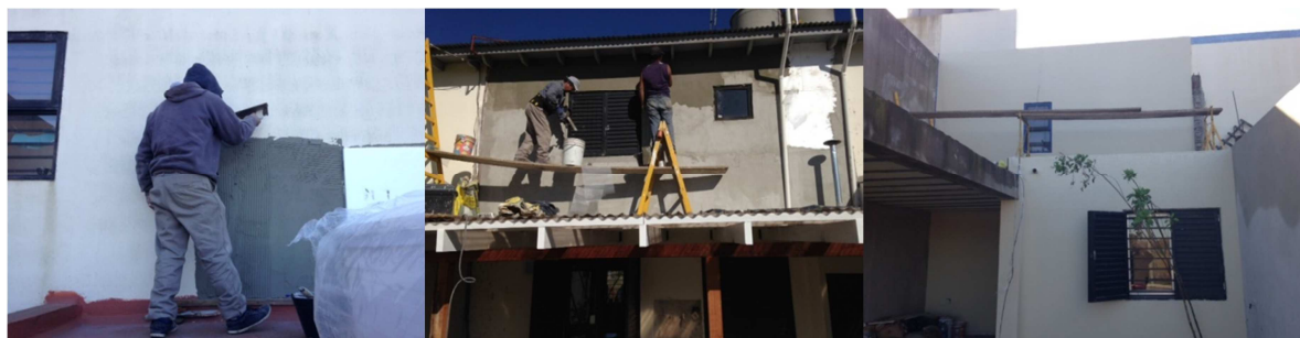
Figura 4: imágenes de la ejecución de la obra de aislación exterior de muros.
